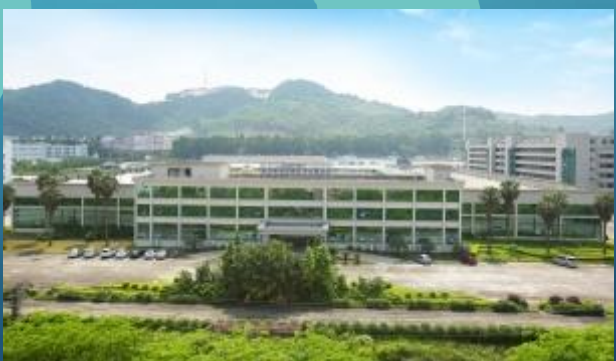
順晟電腦 (金屬沖壓) 廣東東莞鳳崗
